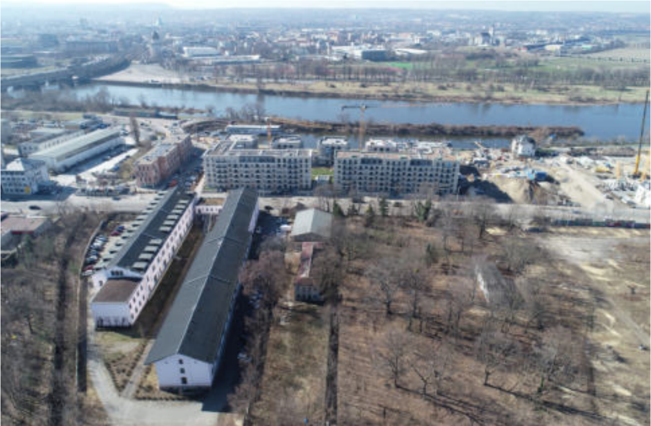
Blick Richtung Hafencity und Elbe © Landeshauptstadt Dresden
